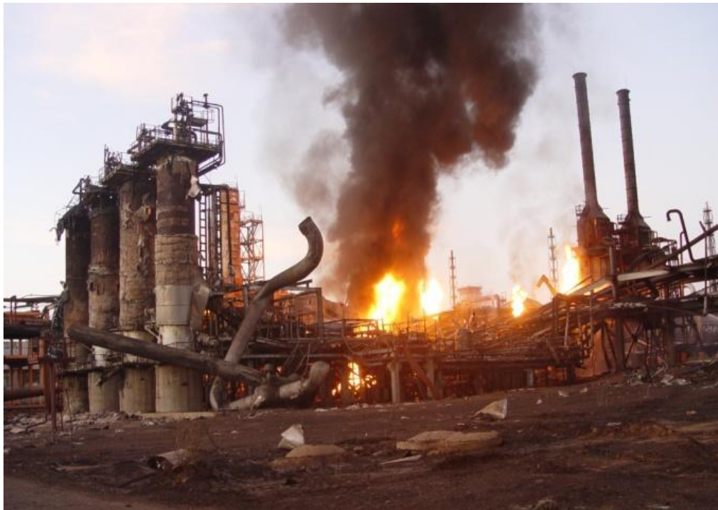
Рисунок 3.5 – Руйнування конструкцій споруд від пожежі
