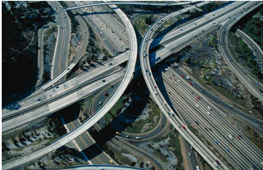
Рисунок 1.13 – Застосування залізобетону в дорожньому будівництві
