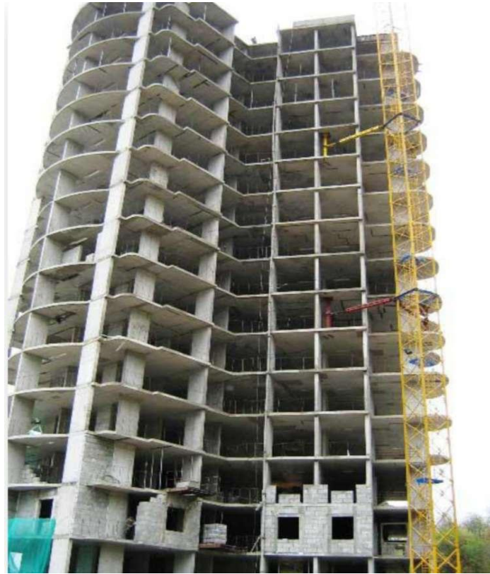
Рисунок 1.9 – Залізобетонна багатоповерхова будівля
