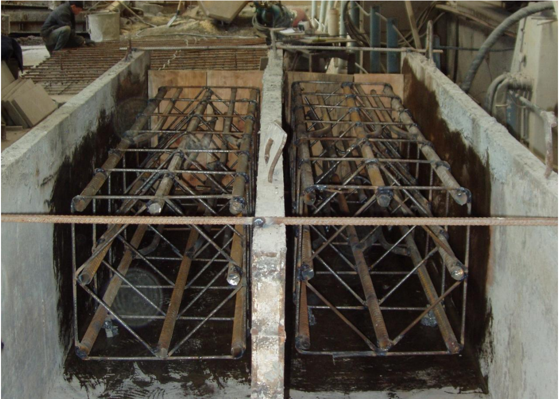
Рисунок 11.1 – Встановлення арматури в опалубку колон
