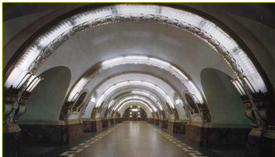
Рисунок 1.14 – Застосування залізобетону при будівництві метрополітенів
