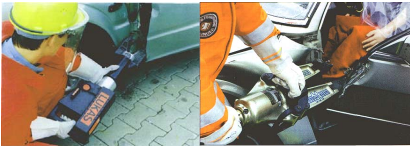
Рис. 4.3 – Технологія видалення передніх дверей
