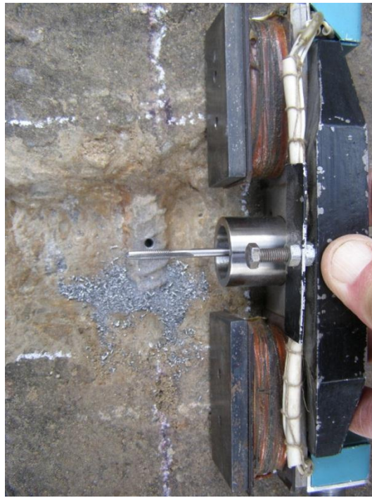
Рис. 1 – Свердлення отворів в стержнях робочої арматури.
