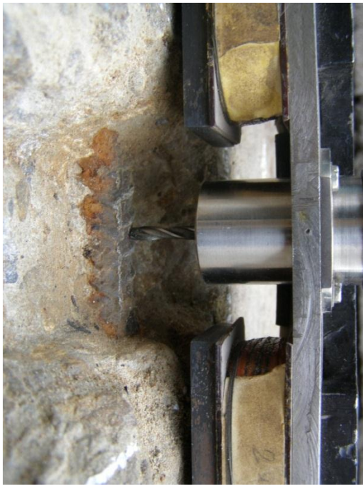
Рис. 1 – Свердлення отворів в стержнях робочої арматури.
