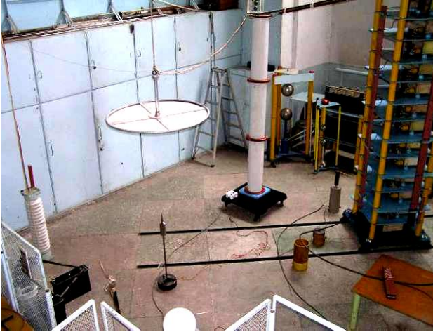
Рис. 9. Общий вид высоковольтного испытательного стенда НИПКИ “Молния” НТУ “ХПИ”, предназначенного для испытания средств молниезащиты технических объектов коммутационным апериодическим импульсом напряжения амплитудой до \pm 1 МВ временной формы 250 мкс/5000 мкс и содержащего в схеме передвижной сверхвысоковольтный емкостный делитель напряжения типа ЕДН-1,2 [16]
