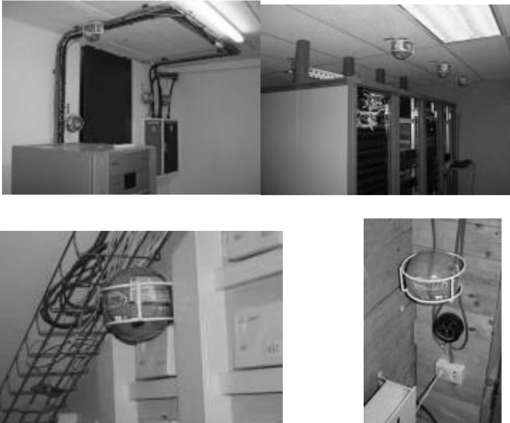
Рис. 3.26 – Модуль порошкового пожежогасіння «ШАР-1»
