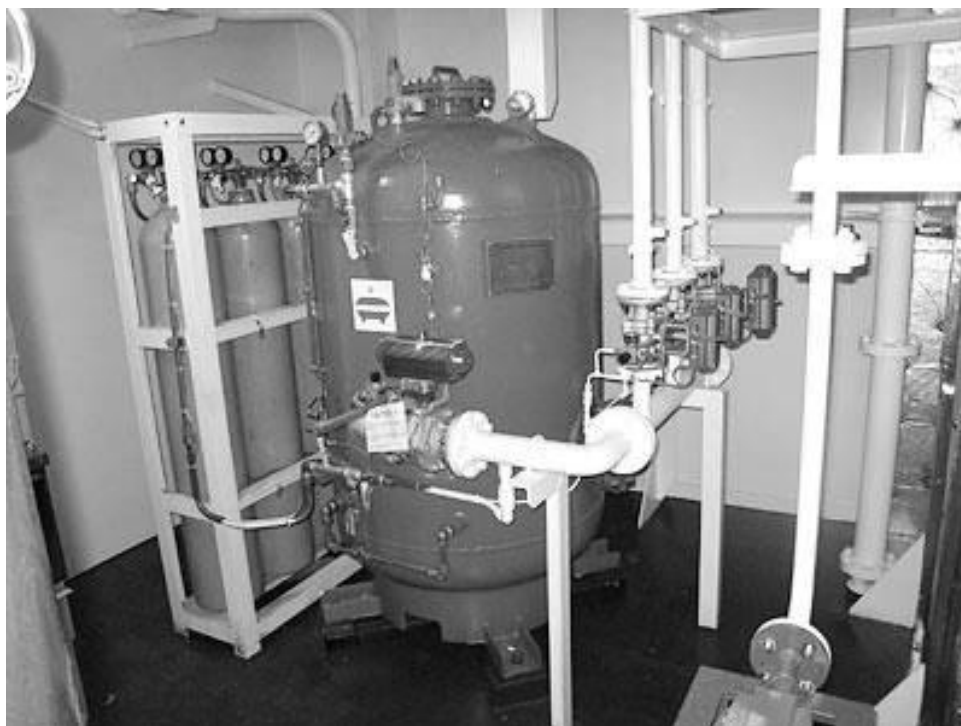
Рис. 3.16 – Загальний вигляд системи порошкового пожежогасіння з централізованим джерелом робочого газу для захисту декількох приміщень DAELIM MARINE CO. LTD
