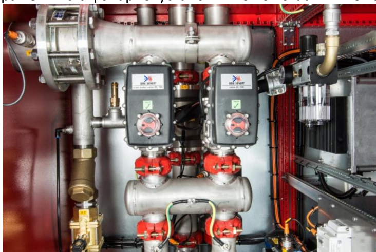
Рис. 3. Стаціонарна установка пожежогасіння One seven
