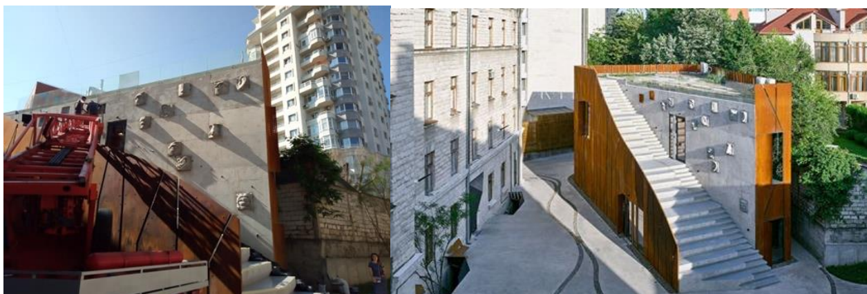
Рис. 11. HUBARTCOR в процессе строительства
