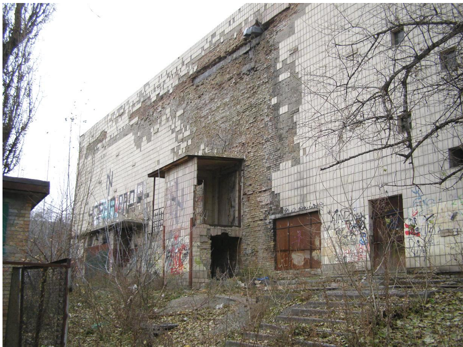
Рис. 4. Вигляд кладки стіни фасаду по осях 10-1
